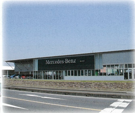
下館サービスセンター
